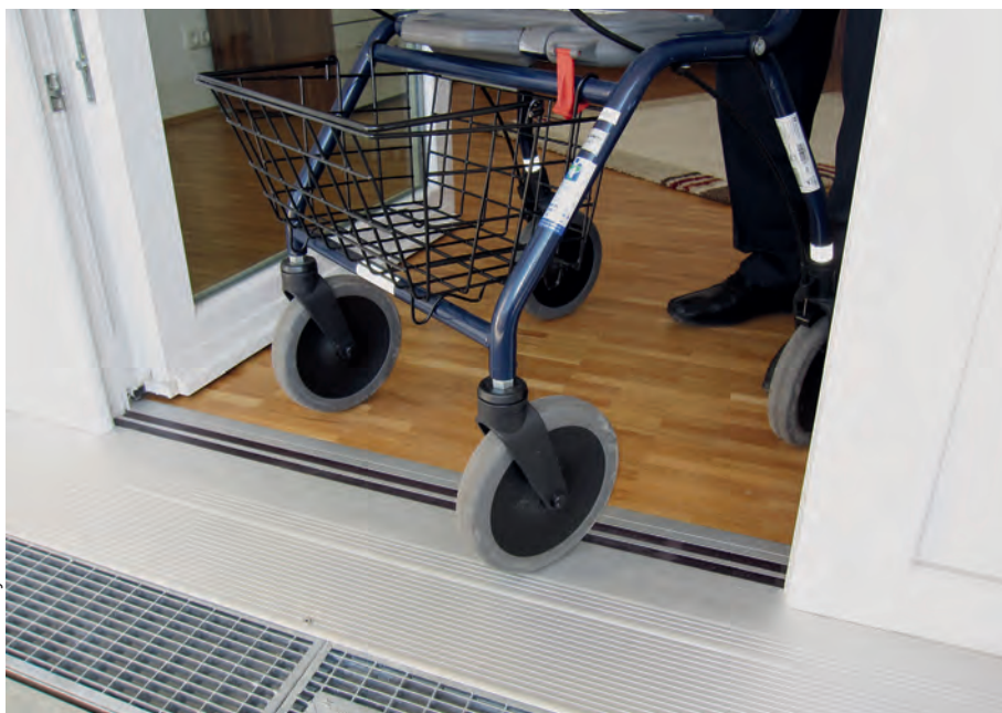
Abb. 1 und 2: Ein tatsächlich schwellenfreier Übergang stellt für ältere Menschen wie auch Kinder eine große Erleichterung dar.
