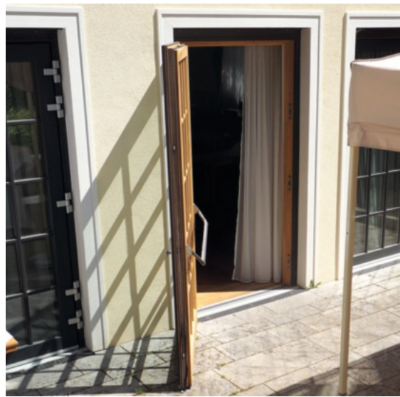
Magnet-Nullschwellen ohne Türanschlag ermöglichen Gästen und Servicepersonal gleichermaßen einen stolper- und barrierefreien Zugang auf die große Veranstaltungsterrasse.
